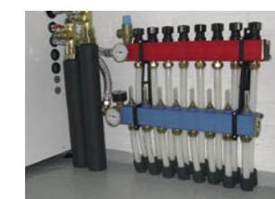
Gulvvarme (lavtemperatur) giver de ideelle betingelser til en varmepumpe (lavt strømforbrug). Hvis hele huset opvarmes med gulvvarme, forbindes anlægget som direkte koblet gulvvarme (ingen blandesløjfe og ekstra cirkulationspumpe).
