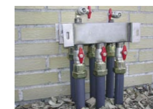
Fordelerrøret til jordslangerne kan enten placeres på en husvæg som vist eller skjules under jorden i en brønd med dæksel.
