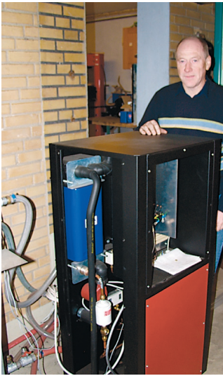
Vagn Tanderup har videreudviklet sit jordvarmeanlæg til en kompakt skabsmodel med selvregulerende behovsstyring.
